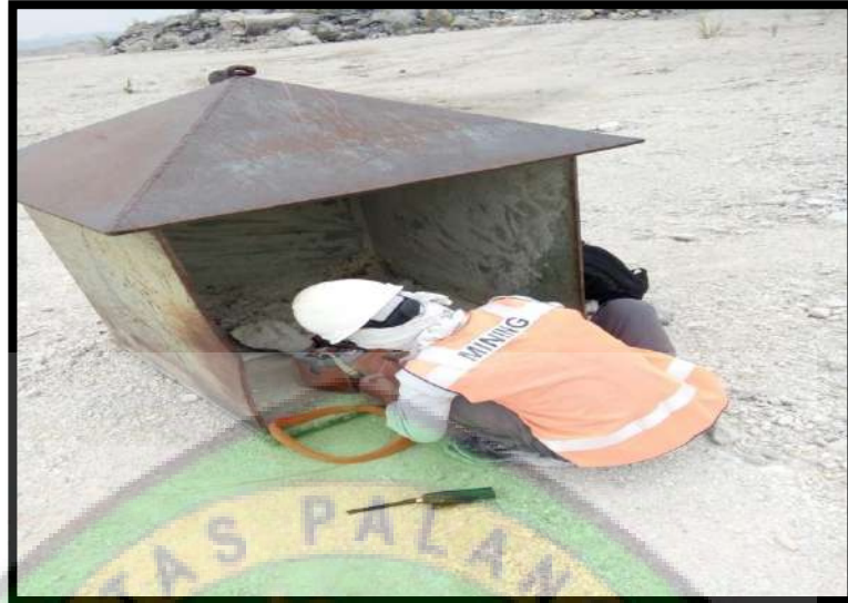
Gambar 4. 8 Perangkaian kabel ledak
